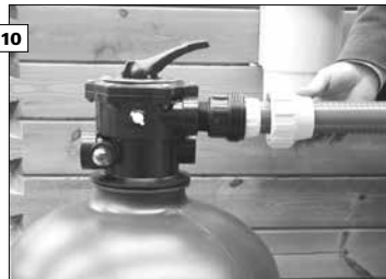
10 La pompe et le filtre sont raccordés à l'aide d'un tuyau semi-rigide.
